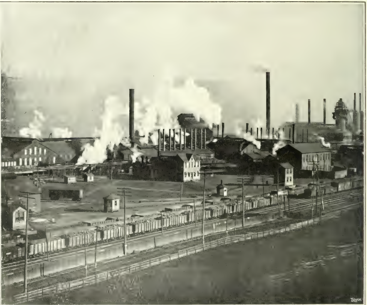
L'USINE EDGAR THOMSON. — Cette usine appartient au trust Carnegie de l'acier. C'est là que se fabriquent presque tous les rails qui sillonnent l'Amérique : il sort journellement de l'usine 60 kilomètres de rails.
